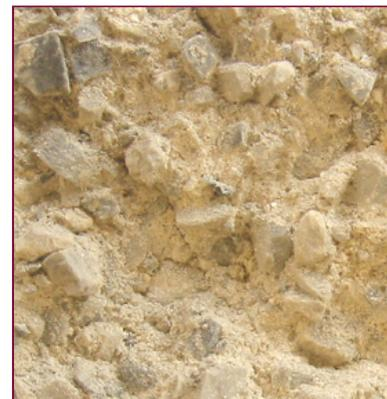
rinzaffo sottostante in calce idraulica ed inerti grossolani
